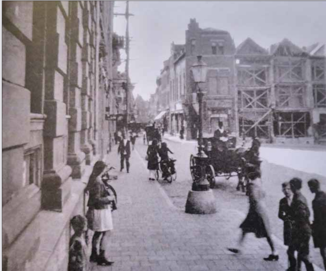
Herstel panden Markt, links op de foto is nog de herbouw van de raadszaal in het stadhuis te zien; op die panden zijn reliëfs aangebracht als herinnering van de herbouw.
