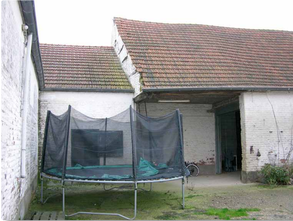
13. Het tussenstuk is ingericht als koestal. Rechts de oorspronkelijke inpandige overkapping voor het droog stallen van geladen karren en wagens, of om van daaruit lading te lossen
