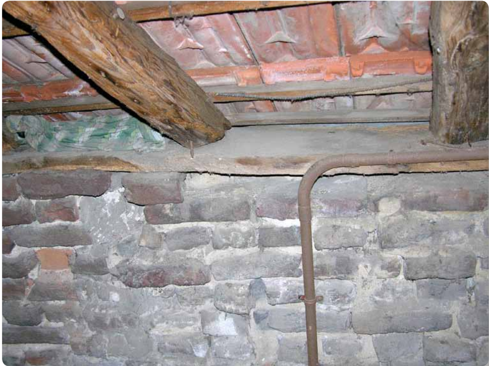
33. Voor het metselwerk van de muren is in het binnenblad veel ruwe baksteen gebruikt. Daarop ligt de muurplaat waarop de authentieke grenen kepers van het dak rusten
