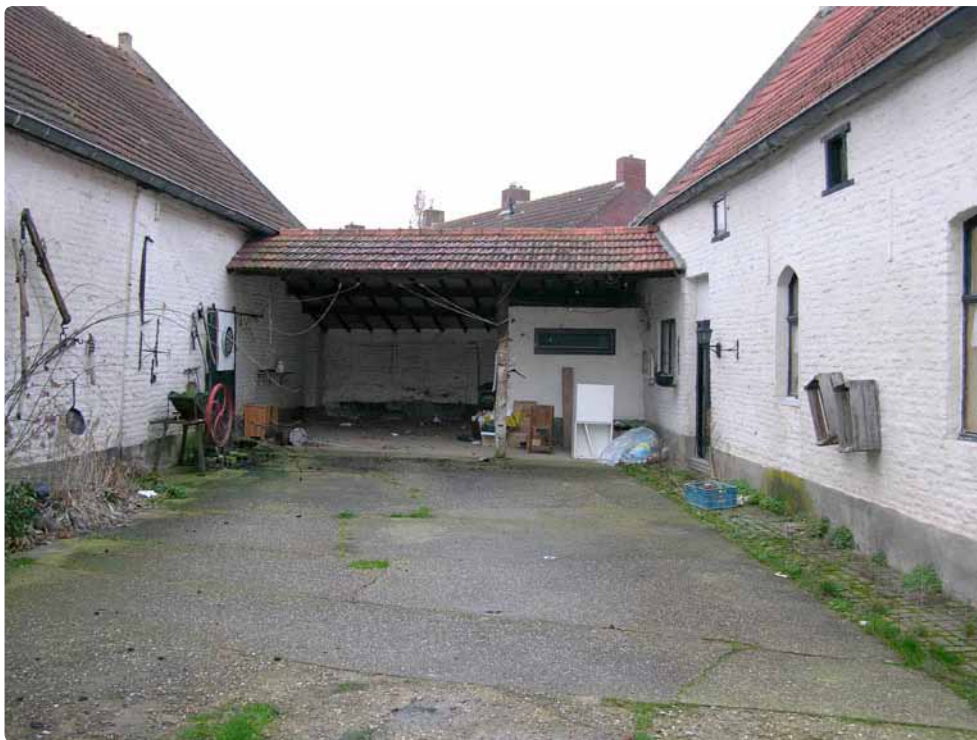
16. Het verbindende stuk tussen schuur en woonhuis, bestaande uit een oude tuinmuur die later is opgehoogd en vrij recent van een afdak is voorzien
