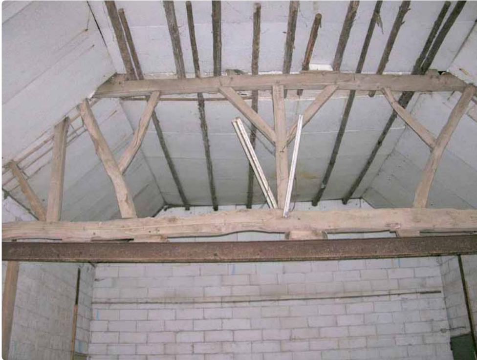
43. De kapconstructie van de schuur is lichter van uitvoering, maar eveneens goed doordacht. De ondervanging met een ijzeren balk van de ankerbalk is gemaakt na het weghalen van de oorspronkelijke standvinkconstructie
