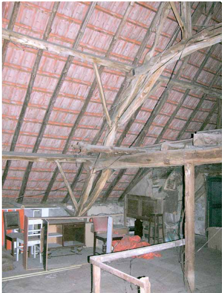
34. De spanten bestaan uit twee gestapelde jukdebalkconstructies en een nokbalkconstructie
