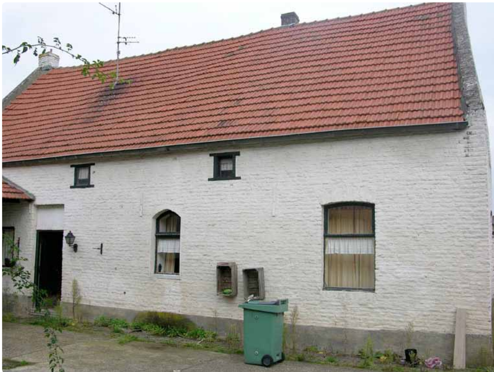
18. De woonhuisgevel met de oorspronkelijke voordeur en later gewijzigde vensters. De raampjes met eiken kozijnen op de verdieping zijn authentiek en waren voorzien van luikjes. Zo kon, in combinatie met de vensters in de kopgevels, de zolder worden geventileerd om broei in daar opgeslagen veldvruchten te voorkomen
