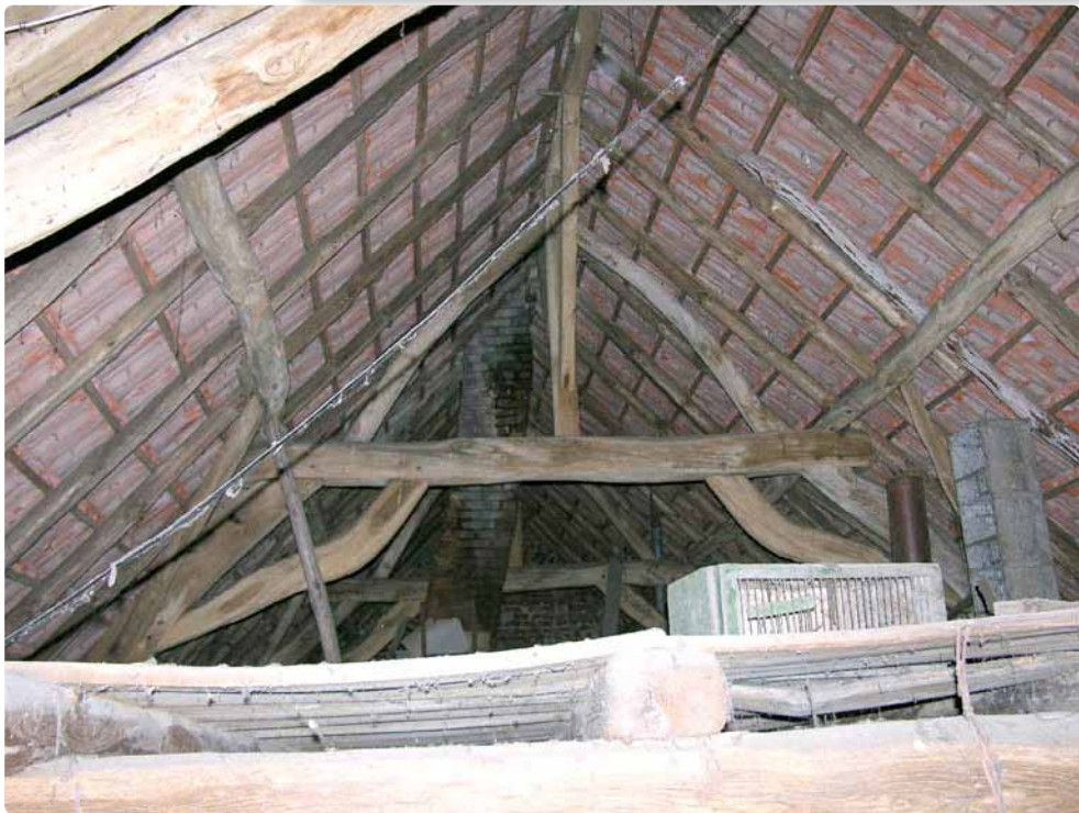
38. De nokconstructie laat de doordachte constructie goed zien
