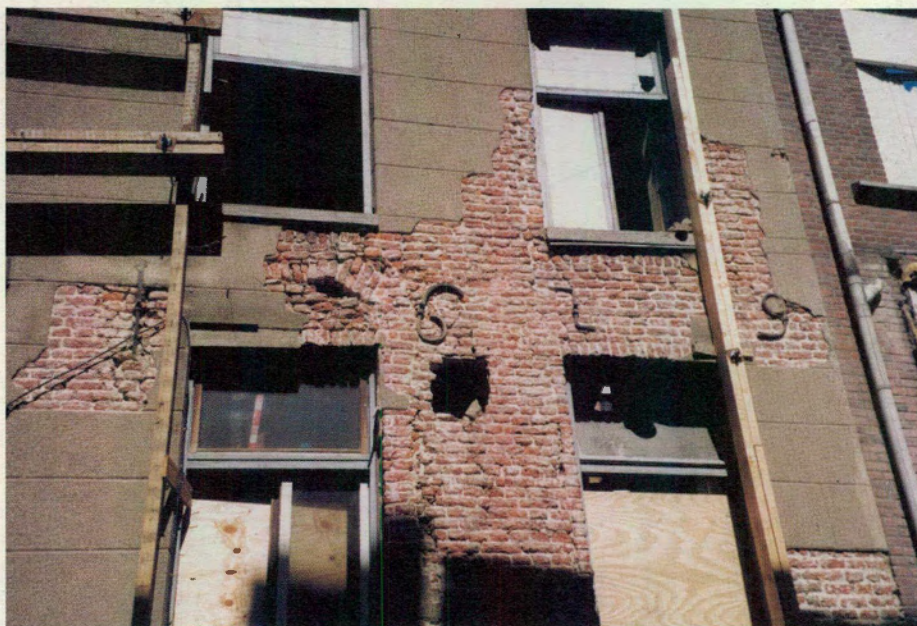
Muurankers uit 1629 in de Luifelstraat. Foto: Dennis Janssen.
