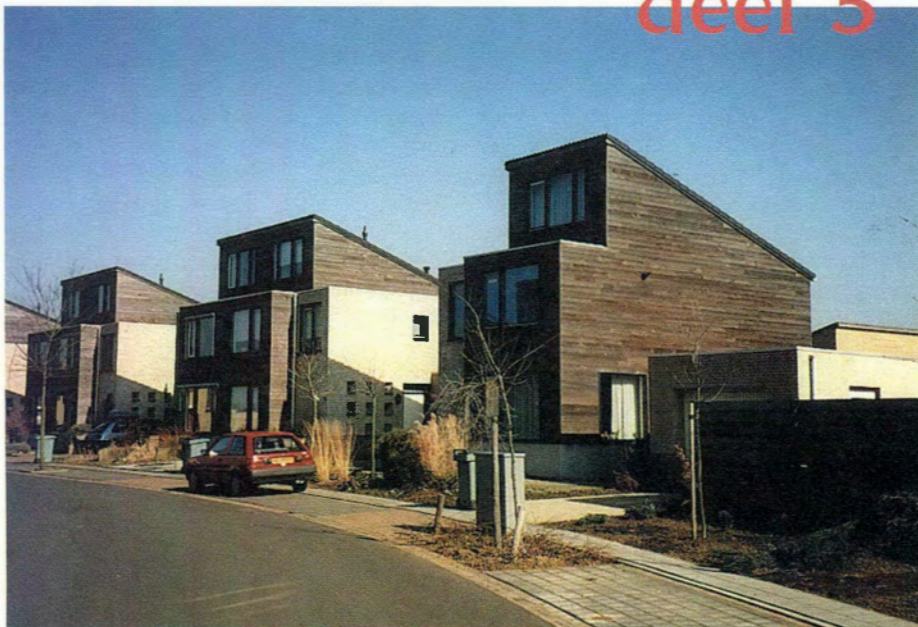
Standerdmolen nr. 115 en verder. Red cedar, een feitelijk zachte, maar op grond van de duurzaamheid toch officieel als hardhout ingeschaalde houtsoort. De grijze kleur is een gevolg van het feit dat deze houtsoort hier onbehandeld is toegepast - niet per se vanwege de fraaie (!) aanblik.
