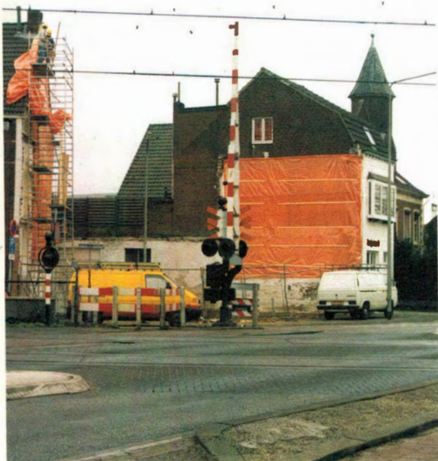
Het 'vernieuwen' van het woonhuis Kapellerlaan 67 in volle gang, nog voor de - verkeerd gedateerde - termijn voor bezwaar tegen de vergunning verlopen was.
