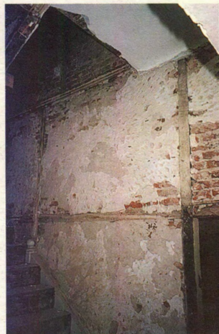
Swalmerstraat 37: trappenhuis met vakwerk; foto beneden: speklagengevel. Foto's: Gerard van de Garde.
