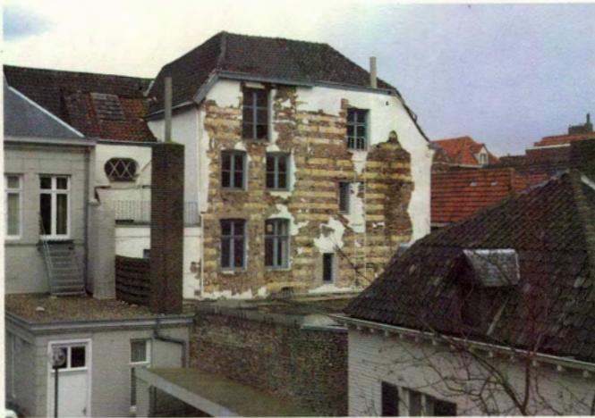
Speklagen (mergel en baksteen) aan de achterzijde Ars-panden. Foto: Peter Wijnands
