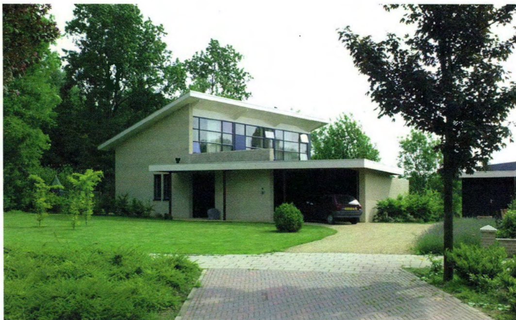
Niet-dragende gevel geheel bestaande uit ruiten (Wijershoflaan 1) Architecten Arend Ottink en Erik Kaptein Foto: Peter Wijnands
