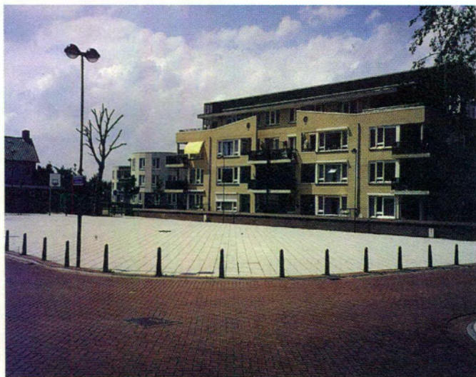
Project: Residentie Laurentius Locatie: Wilhelminalaan 11, hoek Plein 1999 (Maasniel) Architect: Buro Timmermans Foto: Dennis Janssen
