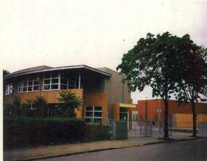
Project: Multifunctionele Accommodatie 'de Velderie' Locatie: blok Hendriklaan - Prins Bernhardstraat - Burgemeester Brouwersstraat Architect: Architectenbureau Duijsens en Meijer Viol Foto: Dennis Janssen
