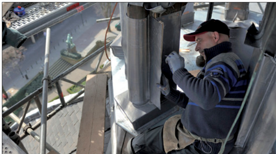
Gerrit van Bakel van Lei- en Dakdekkersbedrijf H.H. Verkoulen bezig met het met lood bekleden van houtwerk van de spits op de koepel van de Munsterkerk Kijk voor meer foto's van de renovatie op: www.harrysegers.nl
