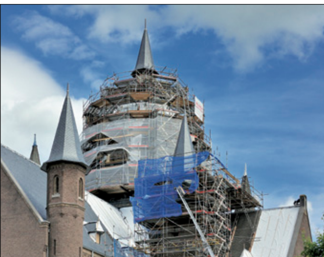
Gerrit van Bakel van Lei- en Dakdekkersbedrijf H.H. Verkoulen bezig met het met lood bekleden van houtwerk van de spits op de koepel van de Munsterkerk Kijk voor meer foto's van de renovatie op: www.harrysegers.nl
