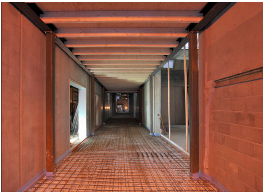
ECI: de in aanbouw zijnde verbindingsgang tussen het poppodium (links) de multifunctionele ruimte en de bioscoopzaal (rechts), aan het eind van de gang liggen de expositieruimten en de entreehal.
