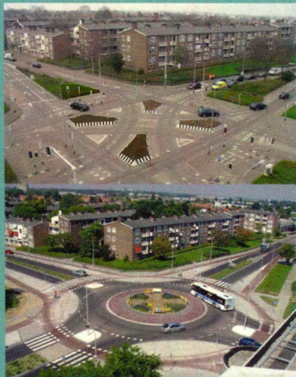
Het kruispunt Oranjelaan-Bredeweg, voor en na de verbouwing, gezien vanaf het Kadastergebouw. Foto's Leonard Fortuin, met dank aan het Kadaster.
