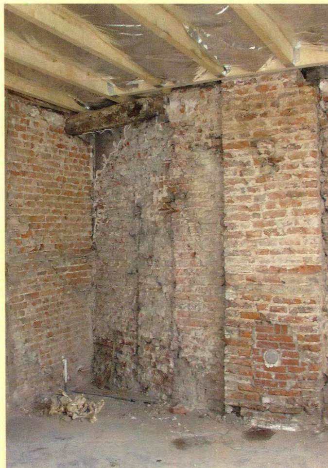
De kromming van de muur van het brughoofd (binnen, vóór de restauratie).
